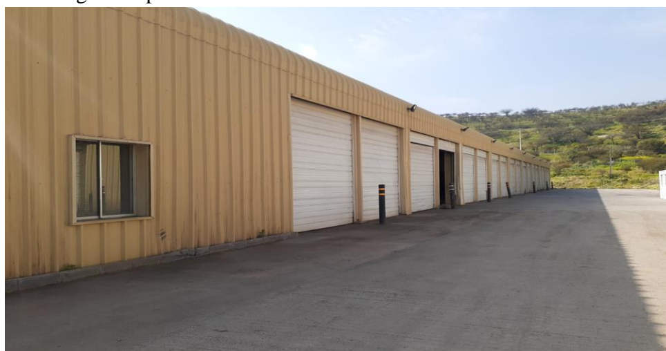
Figura N° 4: Bodega del Depósito de Cargo de Operaciones de Paz. Fuente: Depósito de Operaciones de Paz RLE N° 2 (2023).
