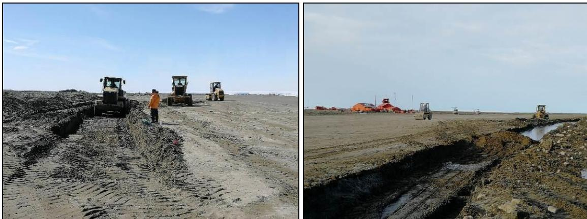
Foto N° 6: Trabajos de rectificación del canal protector de la pista de aterrizaje.
