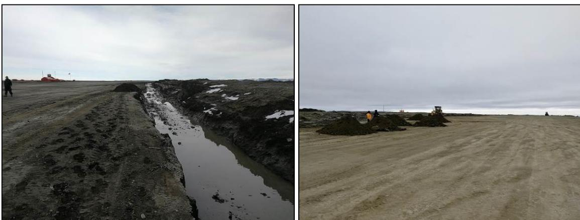
Foto N° 7: Trabajos de relleno, compactación y nivelación sobre lateral de pista.
