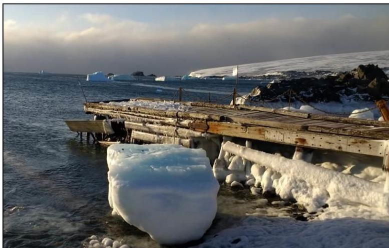
Foto N° 20: Vista lateral del muelle con presencia de hielos que golpean la estructura.
