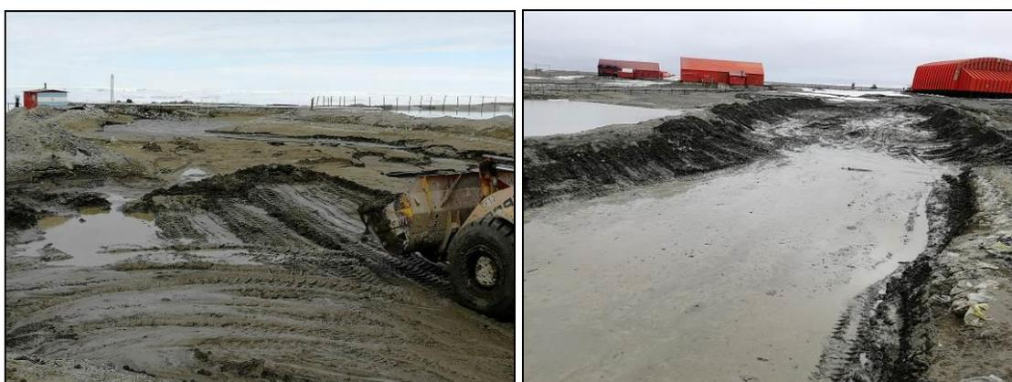
Foto N° 13: Trabajos de saneamiento del lecho, perfilado y ensanchamiento del terraplén perimetral.
