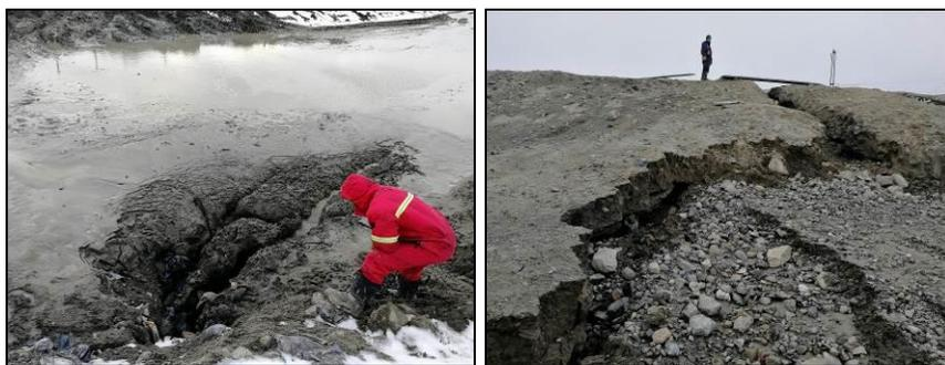
Foto N° 11: Daño ocasionado en el lecho de la laguna (izq.) y en el terraplén (der.).
