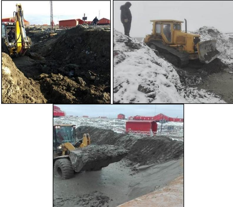
Foto N° 14: Trabajos sobre el sector afectado, excavación, relleno y reparación del terraplén.
