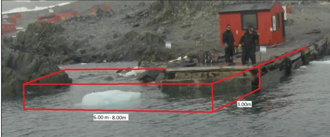
Foto N° 18: Estado original del muelle con el requerimiento de ampliación.
